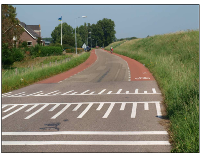
ESEMPIO DI STRADA MODERATA BIDIREZIONALE CON BANDE CICLABILI IN CARREGGIATA
